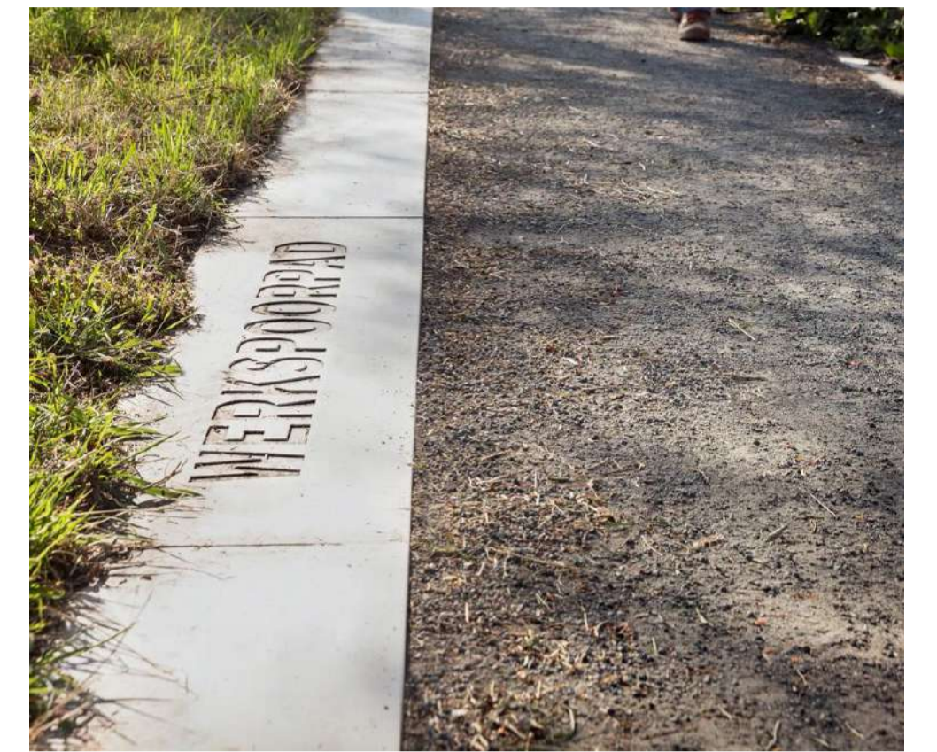
Betonband langs rand van het pad
