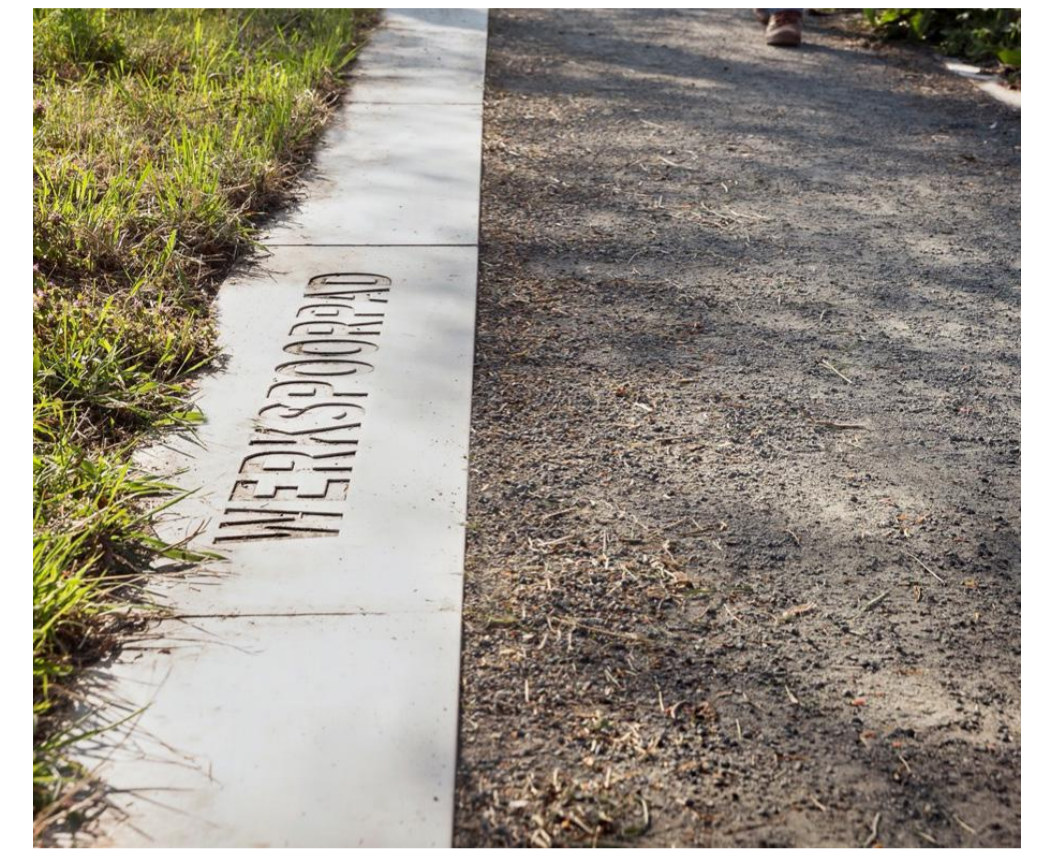
Betonband langs rand van het pad
